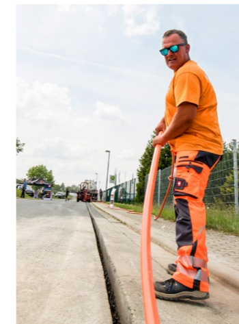
Verlegen eines Kabels in den aufgefästen Boden
